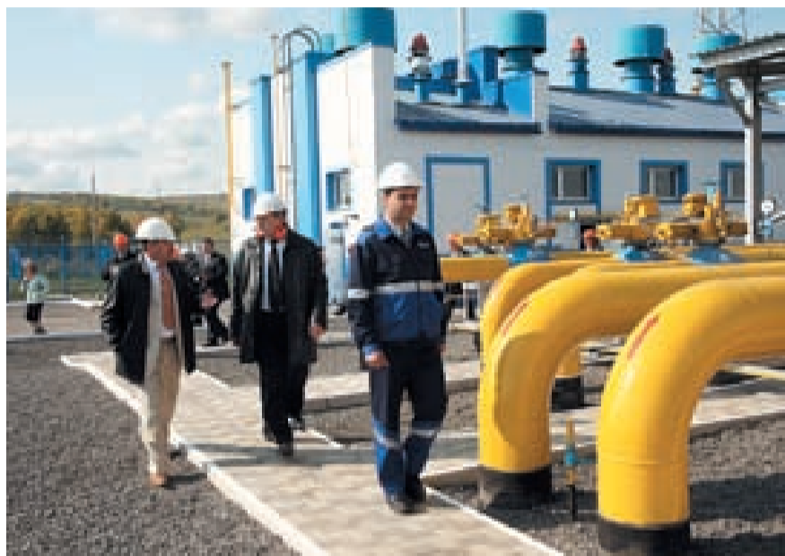
Осмотр ГРС-1 г. Новокузнецка
